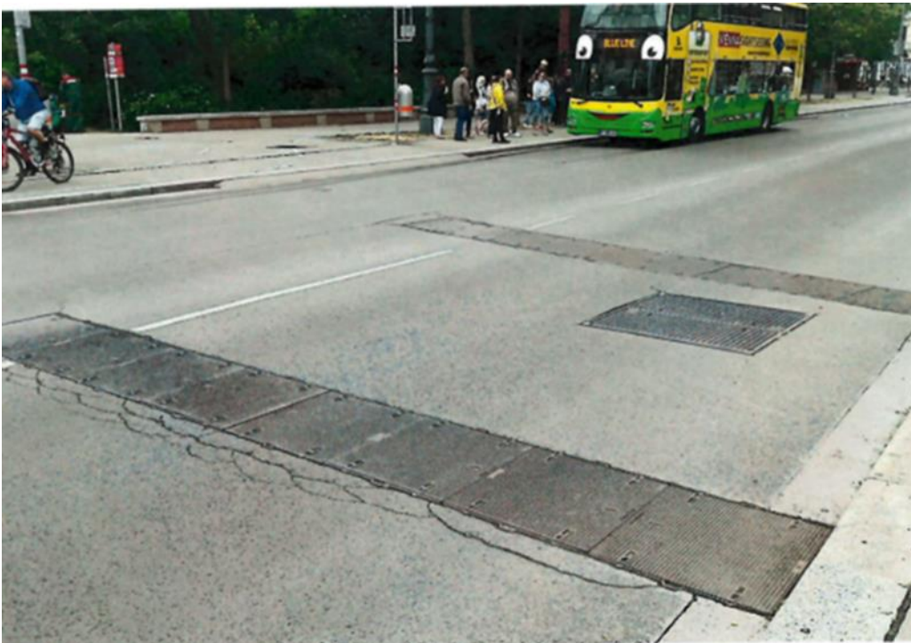
Abbildung 2: Reihenabdeckungen vor der Instandsetzung
