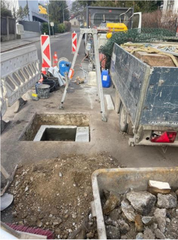
Abbildung 4: Austausch eines Kanaldeckels
