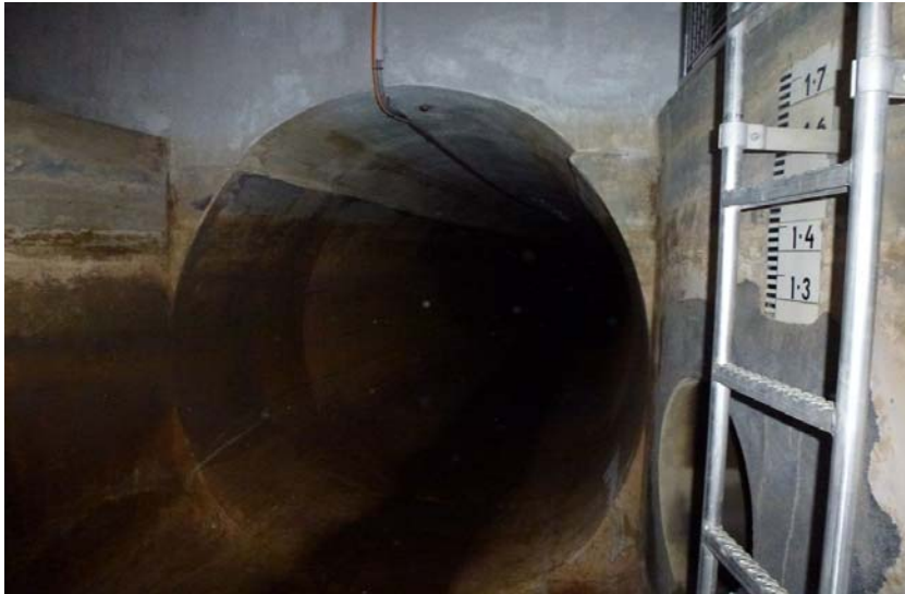
Abb. 6: Blick von der Einlasskammer in den Leitungskanal
