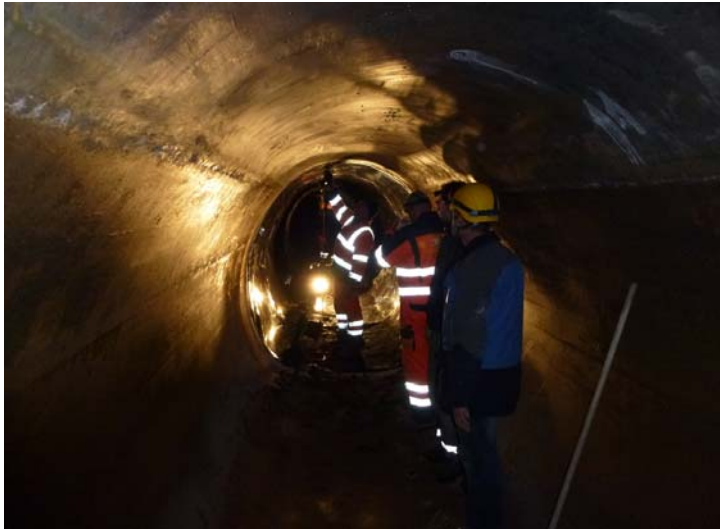
Abb.2: Einbau der Dichtfolie
