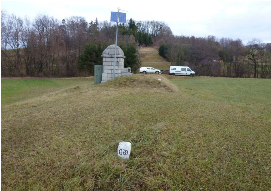
Abb.4: Hektometerstein der Wasserleitungsstrasse bei Turm 66 - Umbachkogel
