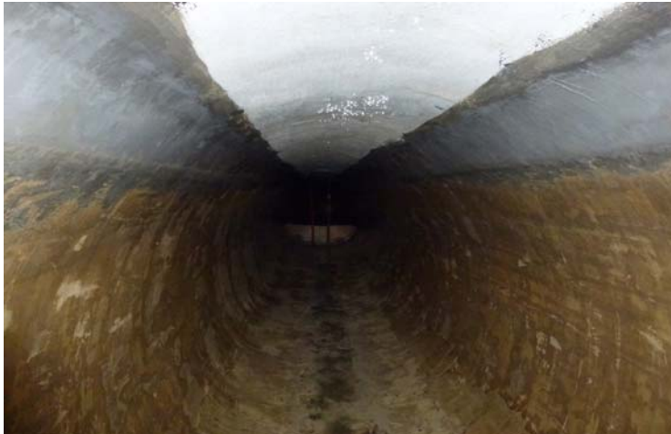
Abb.5: Erhöhung der Schleifputzoberkante
