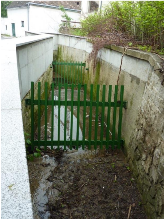
Bild: Einlaufbauwerk und Rechenanlage (Stadtrechnungshof Wien)
