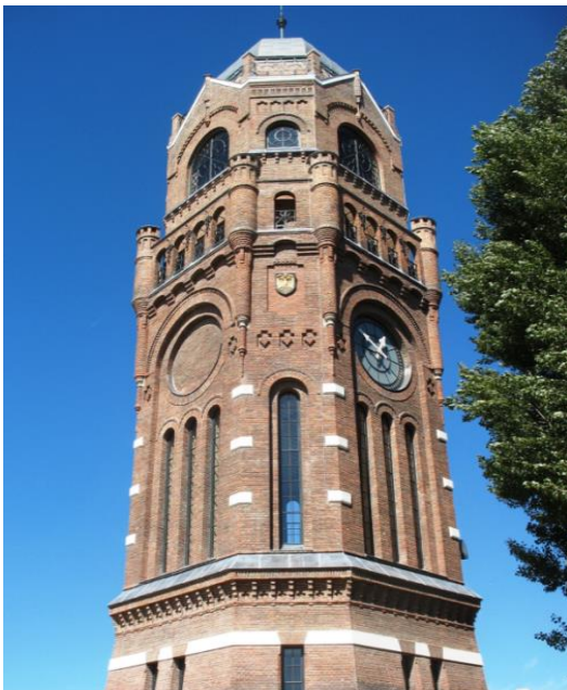
Abbildung 2: Wasserturm nach der denkmalpflegerischen Instandsetzung
