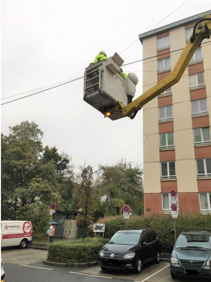
Abbildung 2: Arbeiten an der öffentlichen Beleuchtung im Straßenraum
