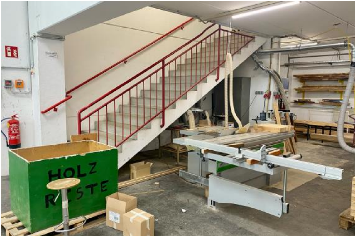
Abbildung 3: Fluchttreppe im hinteren Hallenteil
