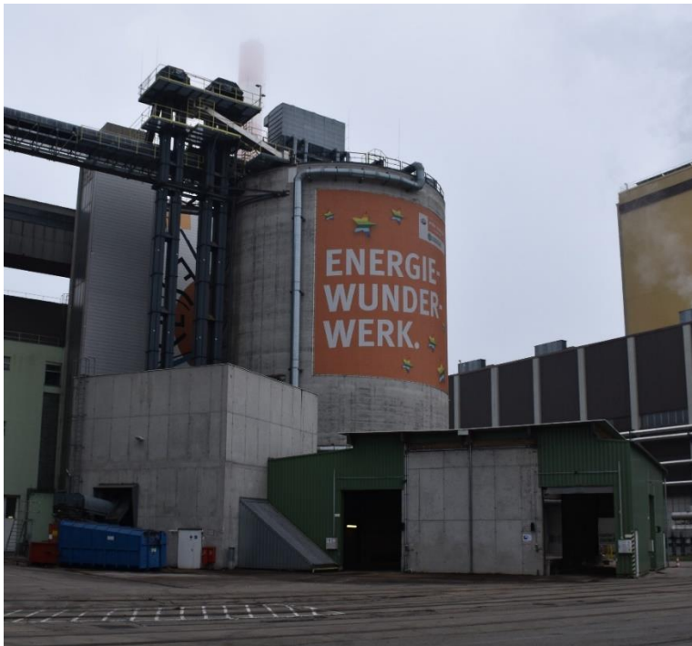
Abbildung 2: Entladegasse und Silo
