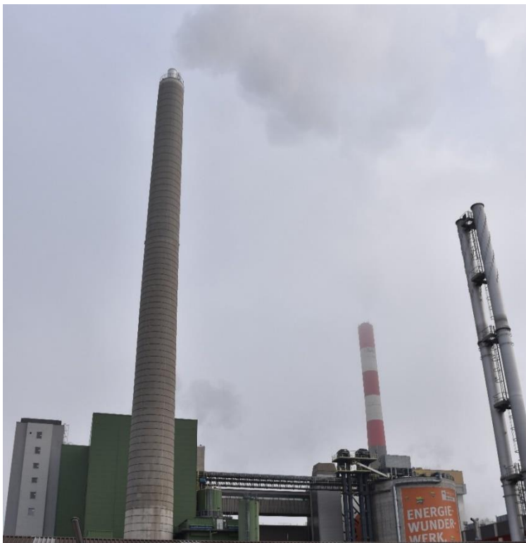
Abbildung 1: Biomassekraftwerk Simmering - Außenansicht
