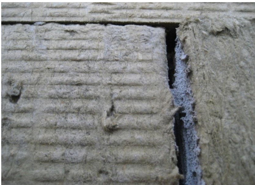
Abbildung 9: Offene Fuge mit Klebemörtel verschlossen
