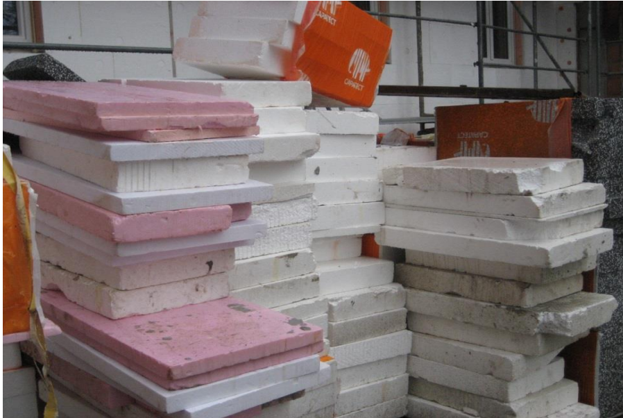
Abbildung 10: Mangelhafte Lagerung von Dämmplatten
