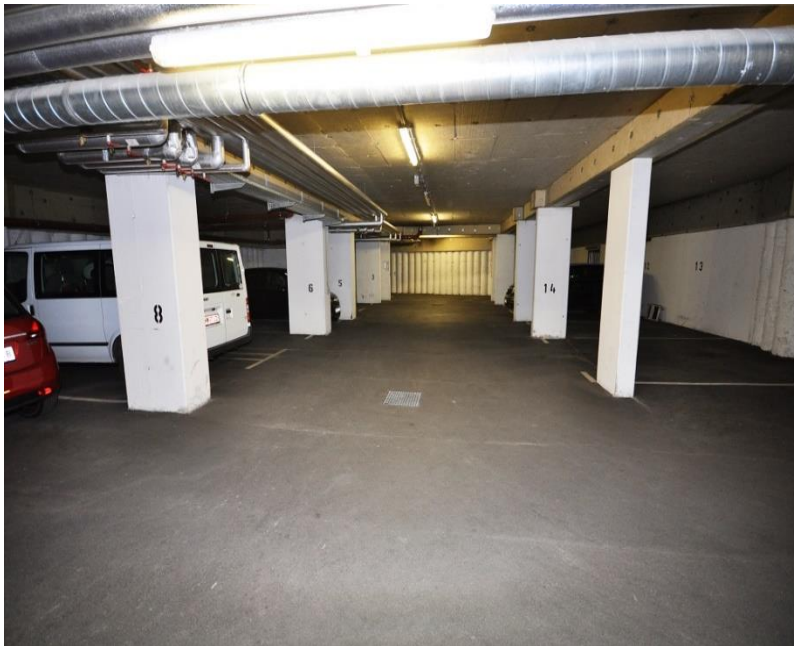
Abbildung 20: Tiefgaragen-Innenansicht Wohnhaus Wien 3, Erdbergstraße 107 - 109, Lechnerstraße 15 - 17
