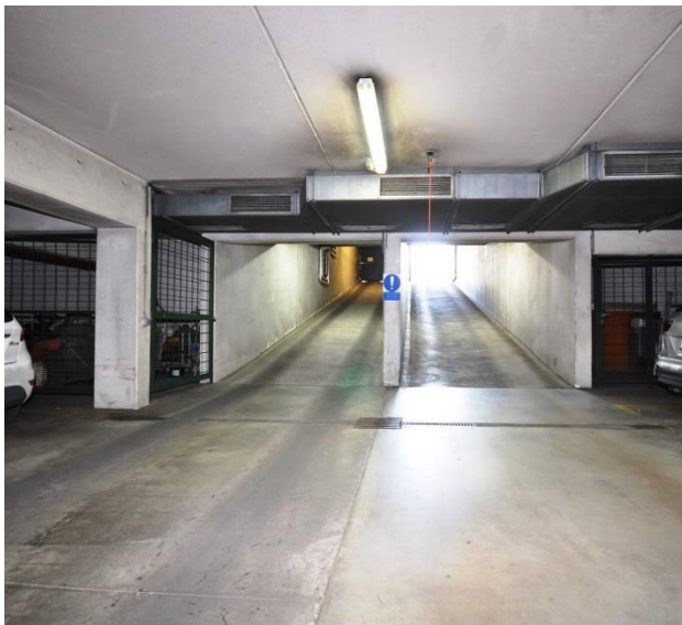
Abbildung 11: Garagenrampe für Ein- und Ausfahrt Wohnhaus Wien 11, Neugebäudestraße 24
