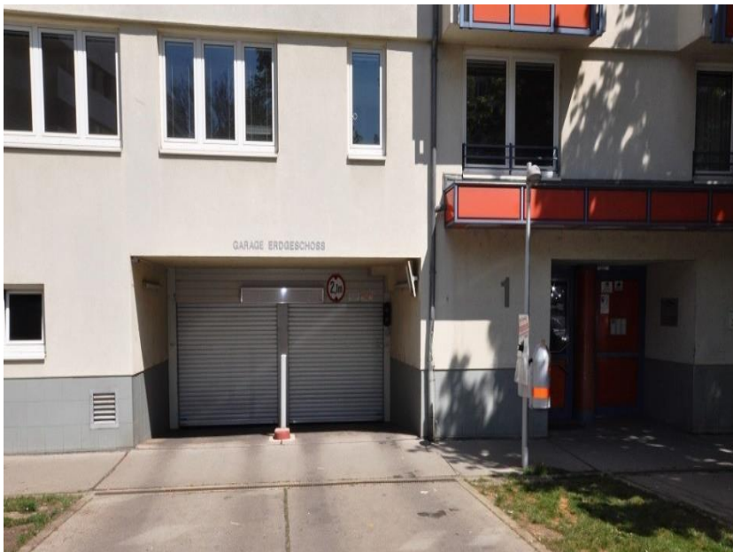
Abbildung 16: Garageneinfahrt-Erdgeschossdeck Wohnhaus Wien 11, Lorystraße 85 - 87
