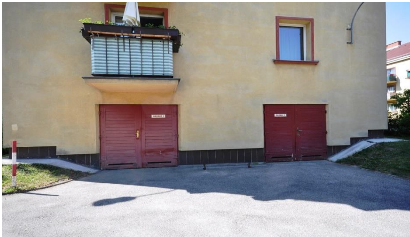
Abbildung 4: Garagenboxen-Außenansicht Wohnhausanlage Wien 11, Lorystraße 114 - 120, Hasenleitingasse 11 - 47
