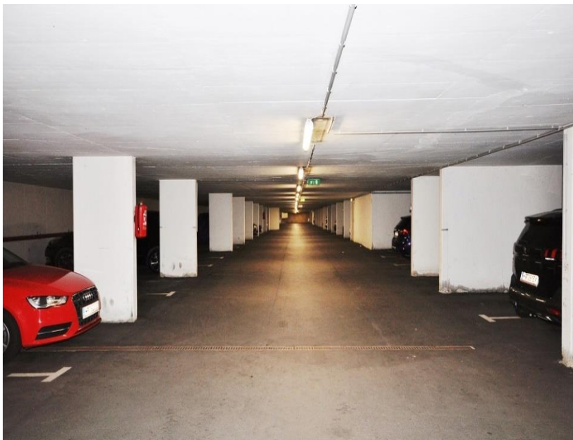
Abbildung 18: Tiefgaragen-Innenansicht Wohnhaus Wien 11, Lorystraße 85 - 87
