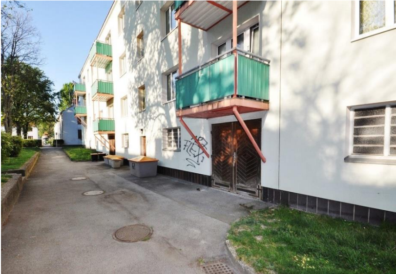
Abbildung 13: Garagenboxen-Außenansicht Wohnhaus Wien 21, Justgasse 24 - 28
