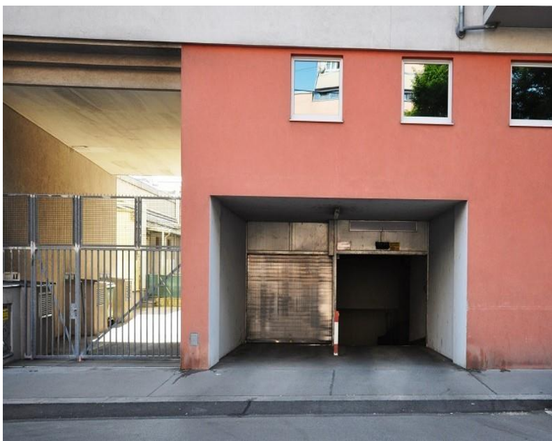
Abbildung 19: Garageneinfahrt Wohnhaus Wien 3, Erdbergstraße 107 - 109, Lechnerstraße 15 - 17
