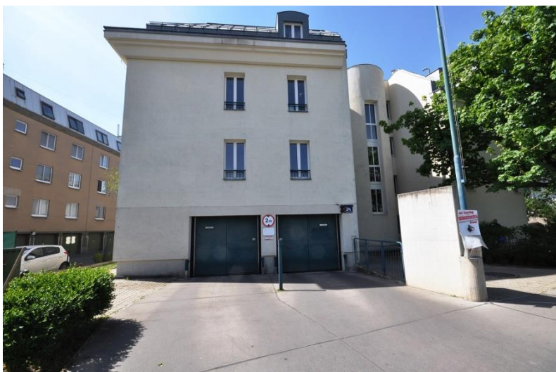
Abbildung 10: Garageneinfahrt Wohnhaus Wien 11, Neugebäudestraße 24
