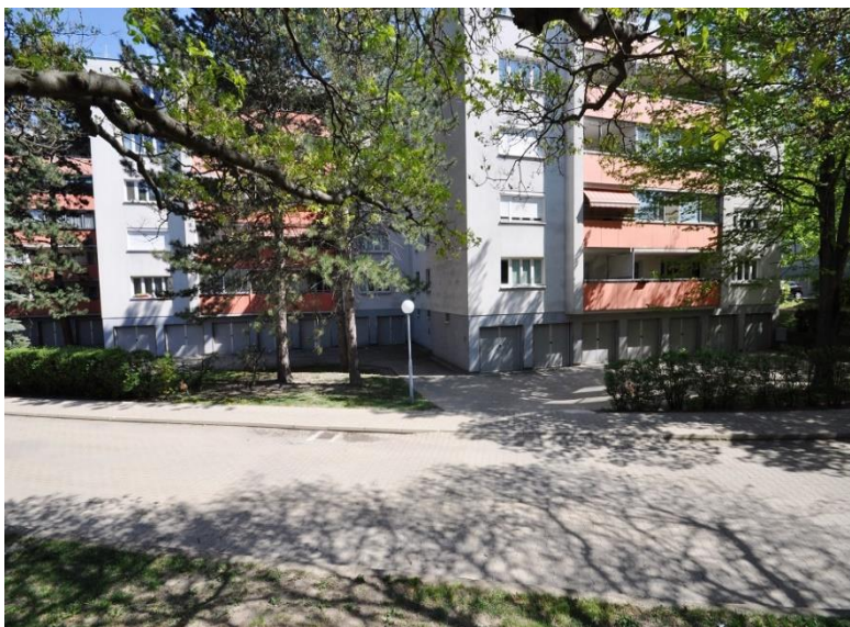
Abbildung 8: Garagenboxen-Außenansicht 3/Stiegen 11 bis 13, Wohnhausanlage Wien 11, Lorystraße 124 - 132, Am Kanal 97 - 103
