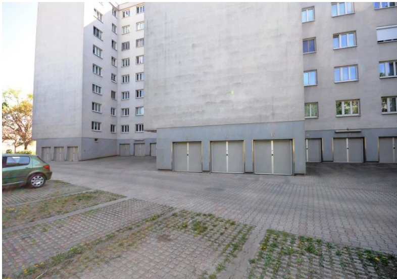
Abbildung 7: Garagenboxen-Außenansicht 2/Stiegen 7 bis 10, Wohnhausanlage Wien 11, Lorystraße 124 - 132, Am Kanal 97 - 103
