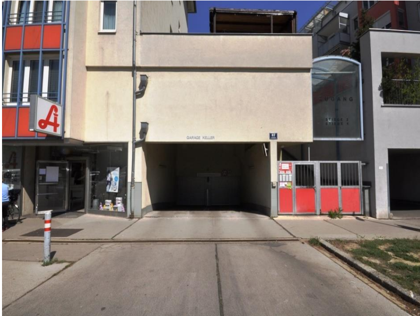
Abbildung 15: Garageneinfahrt-Kellerdeck Wohnhaus Wien 11, Lorystraße 85 - 87
