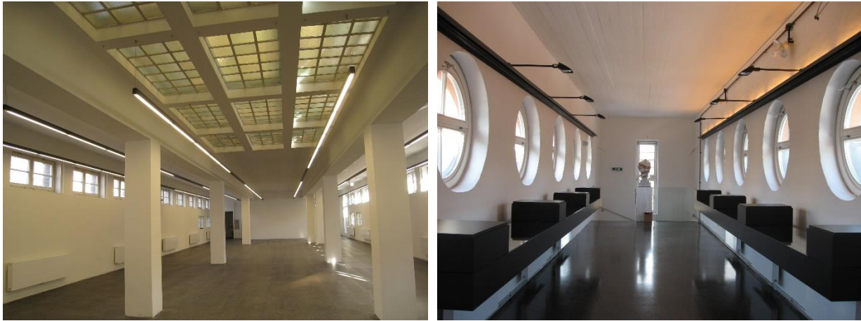
Abbildung 7: Zustand des Mietgegenstandes nach der Renovierung
