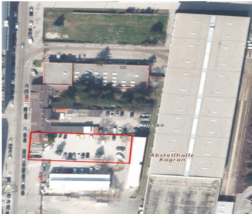
Abbildung 2: Luftaufnahme Bahnhof Kagran mit eingezeichneter Liegenschaft in Wien 22, Attems-gasse 4
