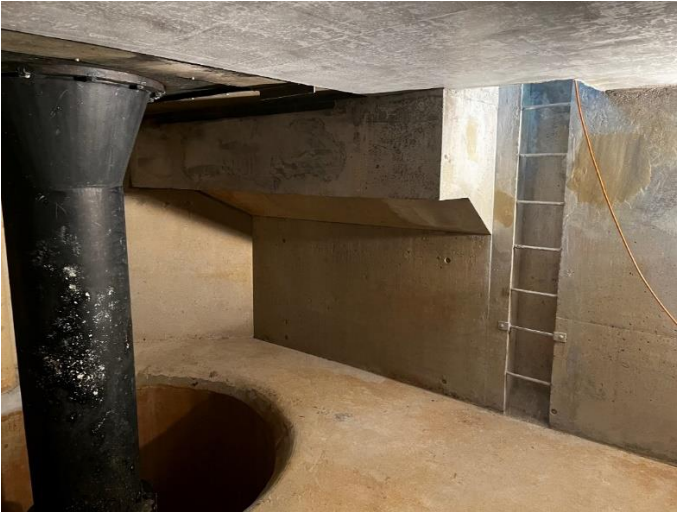
Abbildung 5: Betonsanierung in der Pumpenkammer 2
