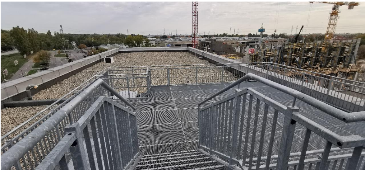
Abbildung 8: Neu errichtete Aussichtsplattform am Dach des Auslaufbauwerkes
