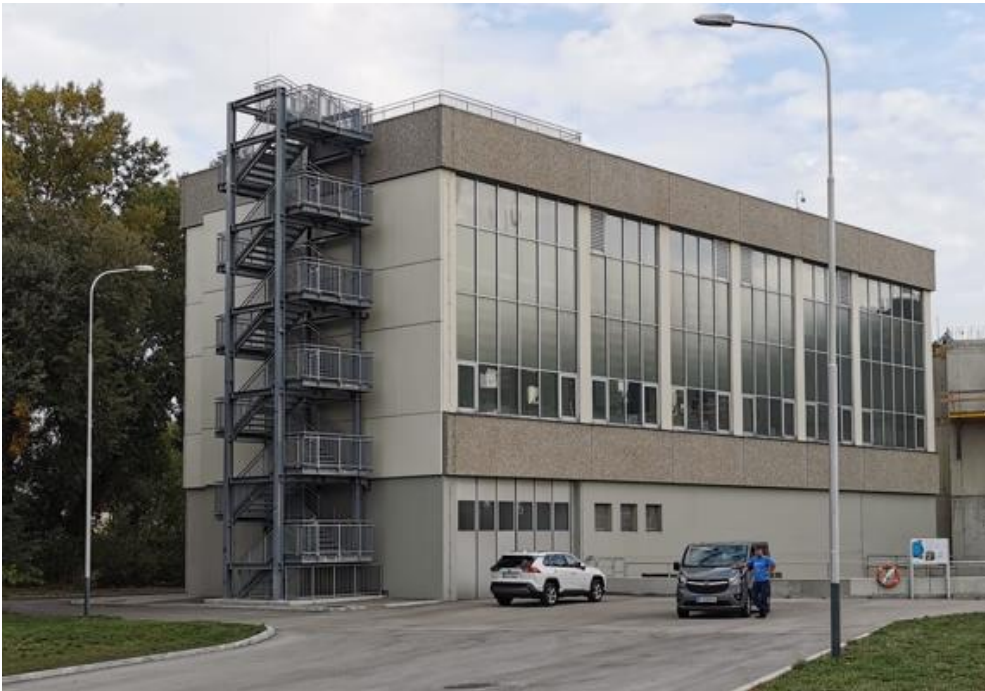
Abbildung 7: Auslaufpumpwerk samt außenliegendem Treppenturm
