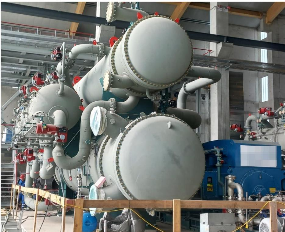
Abbildung 13: Baustelle der Großwärmepumpen bei der Kläranlage Simmering (März 2023)
